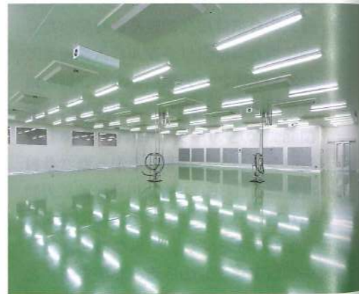
製造室（製袋機設置前）
